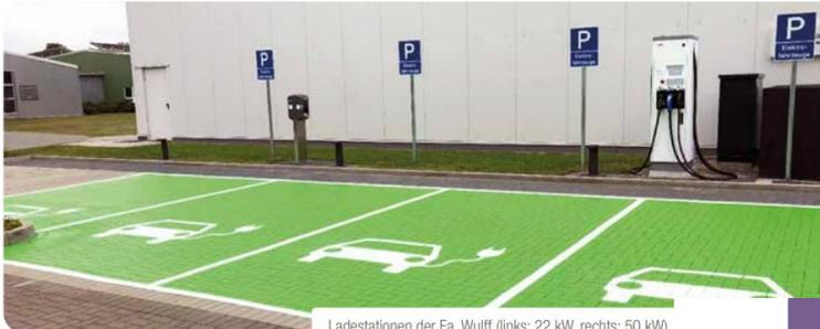
Ladestationen der Fa. Wulff (links: 22 kW, rechts: 50 kW)
